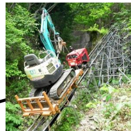
② 3 トン用モノレールで定置式クレーン (2.8 トン) を運ぶ
